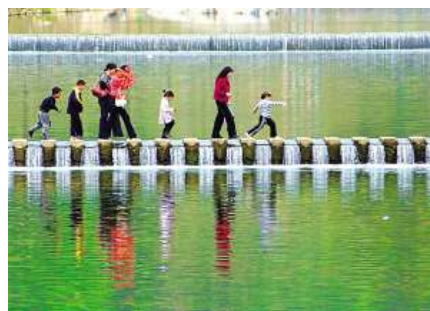
奉化大堰镇清水河道
