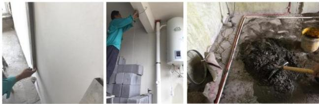
(1) 放线 在墙面、地面弹出垂直及水平砌筑线，用墨斗弹出墨线，作为砌筑控制线，保证砌筑墙体平整。
