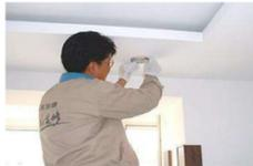
(3) 将预留位的电线拉出来，即可按照灯具的安装说明安装灯具，通常在接线方式上为相线进开关，通过开关进灯头，零线直接进灯头。
