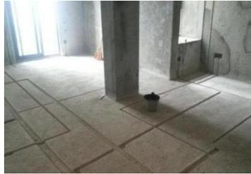
② 电路改造严禁将承重墙体的受力钢筋切断，严禁在承重结构如梁、柱上打洞穿孔。
