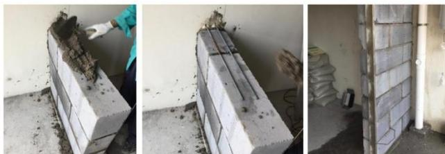
(4) 砌筑 垂直度连续砌筑，砖缝宽度应控制在8-12mm，砖缝处砂浆应饱满，均匀密实。
